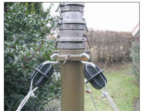
Bild 3: Mit Weidezaunisolatoren aus der Landwirtschaft kann der Mast abgespannt werden.
